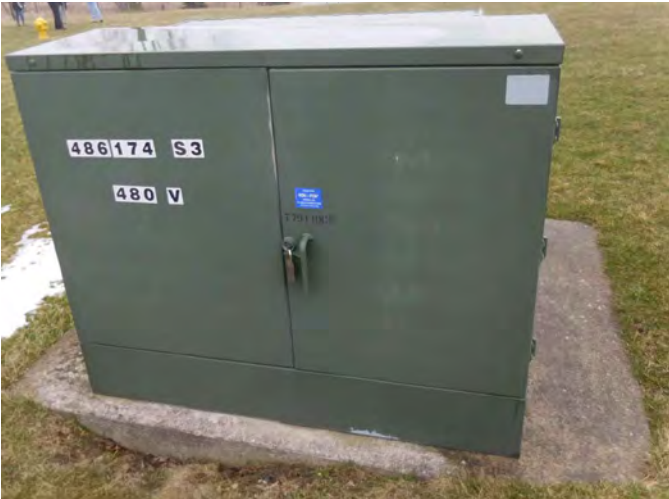
5 EXISTING TRANSFORMER SCALE: N.T.S.
